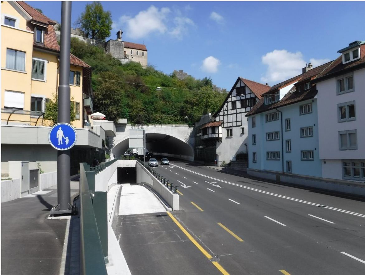
Blick vom Falken auf die Bustunnelausfahrt Mellingerstrasse sowie dem Schlossbergtunnel
