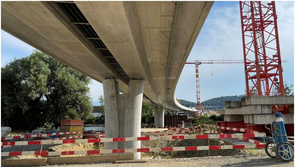
Bis im Frühling 2023 folgen noch Fertigstellungs- und Umgebungsarbeiten
