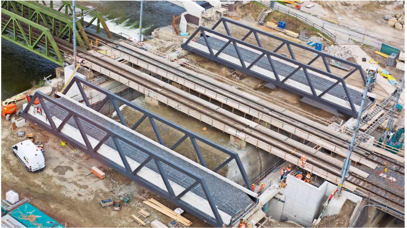
10 | Fertig gestellte Brückenträger der SBB-Brücken Reusszopf inkl. Vorschotterung vor dem Einschub. 10 | Supports achevés des ponts CFF Reusszopf avec pré-cloisonnement avant installation.
