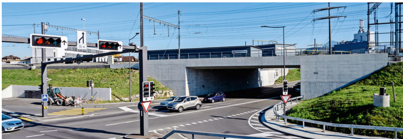
12 | Die neue SBB-Überführung Emmenfeld-Ibach. (Foto: Emch+Berger WSB).
