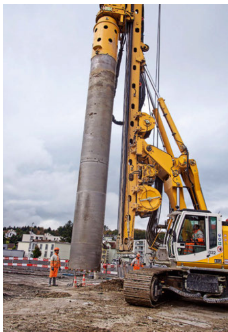
8 | Pfahlfundationsgerät. 8 | Engin de fondation sur pieux.
