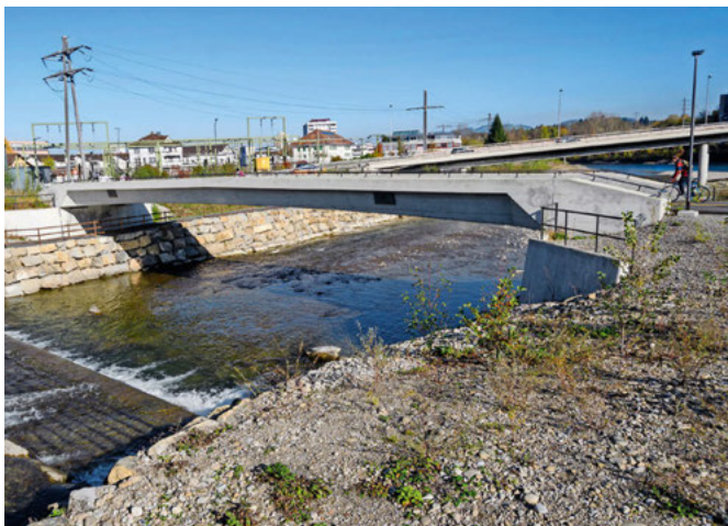
11 | Die Reusszopfbrücke Nord dient dem Langsamverkehr (Foto: Emch+Berger WSB). 11 | Le Reusszopfbrücke Nord sert au trafic lent (photo: Emch+Berger WSB).
