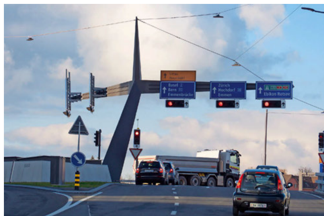
4 | Der Signalmast «Corcovado» markiert den Brückenanfang.
