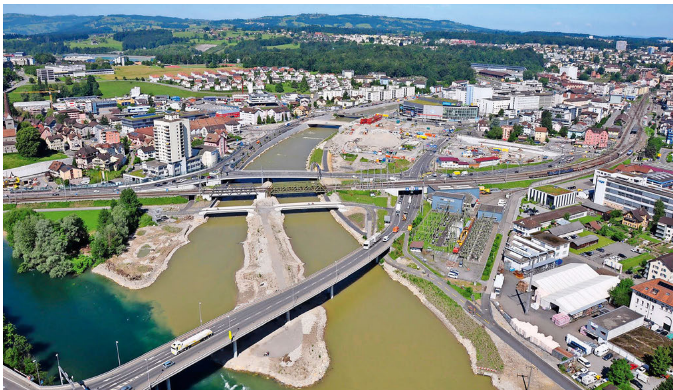
2 | Mündung der Kleinen Emme in die Reuss: Hinter der bestehenden Ibachbrücke sind die Reusszopfbrücken, die SBB-Brücken Reusszopf, die Reussbühlbrücke und die Untere und Obere Zollhausbrücke sichtbar. In der Verlängerung der Ibachbrücke unterquert die Reusszeggstrasse das Bahntrasse unter der SBB-Überführung Emmenfeld-Ibach (Foto: Flugaufnahme Juni 2016).
