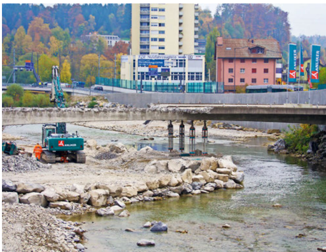
6 | Teilabbruch einer Zollhausbrücke.
