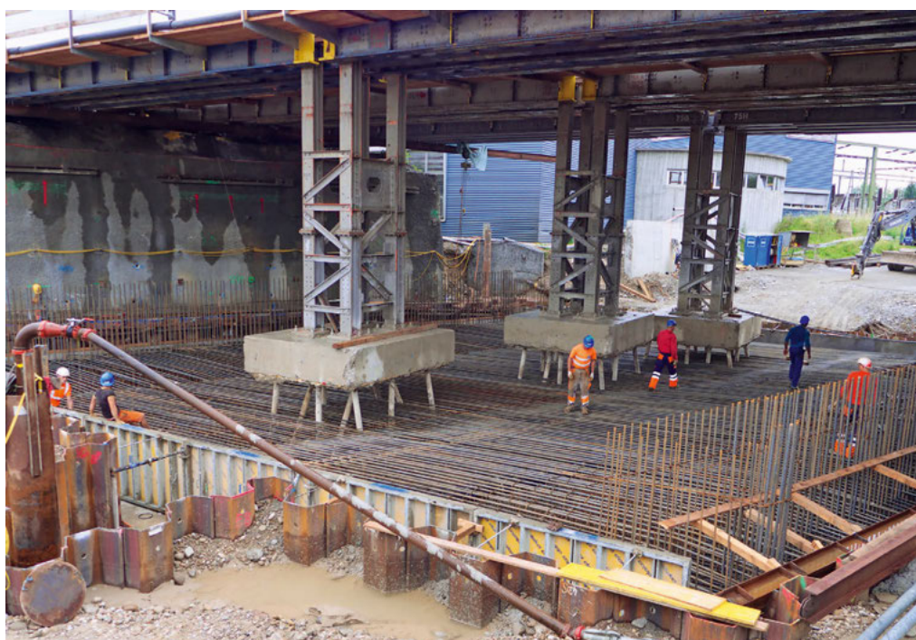
13 | Bauzustand der SBB-Überführung Emmenfeld-Ibach: Verlegen der Bodenplattenbewehrung unter den Hilfsbrückenjochen im Juli 2014.
